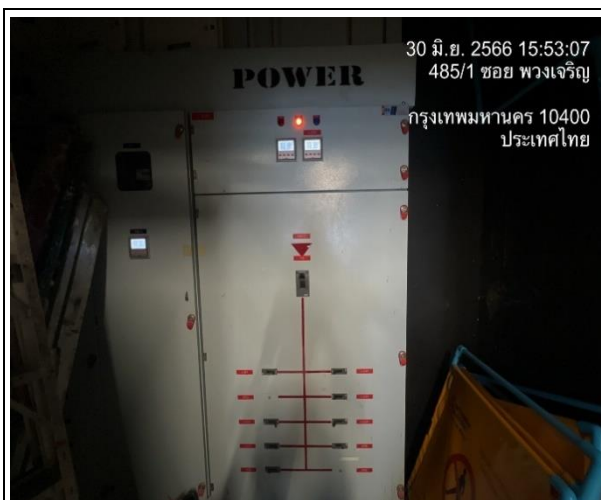
ภาพที่ 12 ระบบมอเตอร์ไฟฟ้าของระบบบำบัดน้ำเสีย
