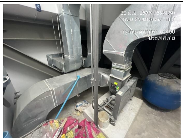
ภาพที่ 11 พัดลมดูดอากาศในห้องมูลฝอยเปียก
