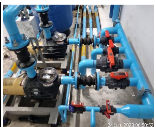
ภาพที่ 18 ระบบกรองน้ำสระว่ายน้ำ
